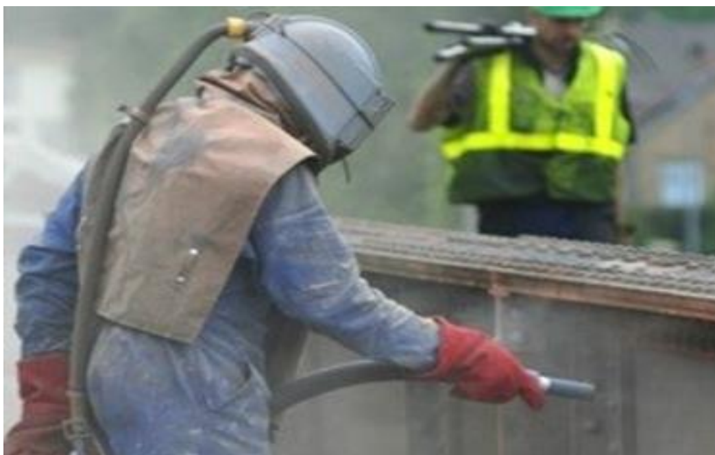
Figura 1: Preparação de superfície por jateamento Fonte: Mejia (2014).
