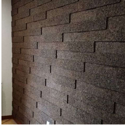
Figura 3: Aglomerado de cortiça expandida utilizado em revestimento de parede. Fonte: Inex Revestimentos.
