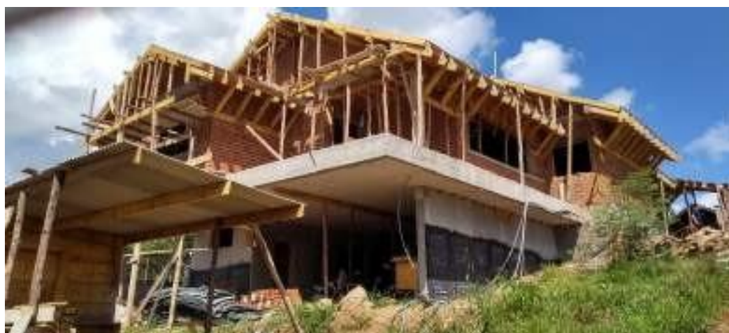
Figura 01: perspectiva da residência
