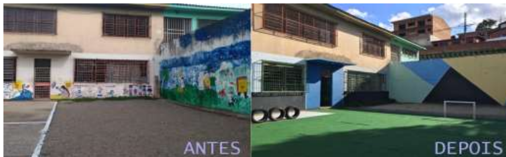
Figura 4 - Fotos antes e depois da reforma.
